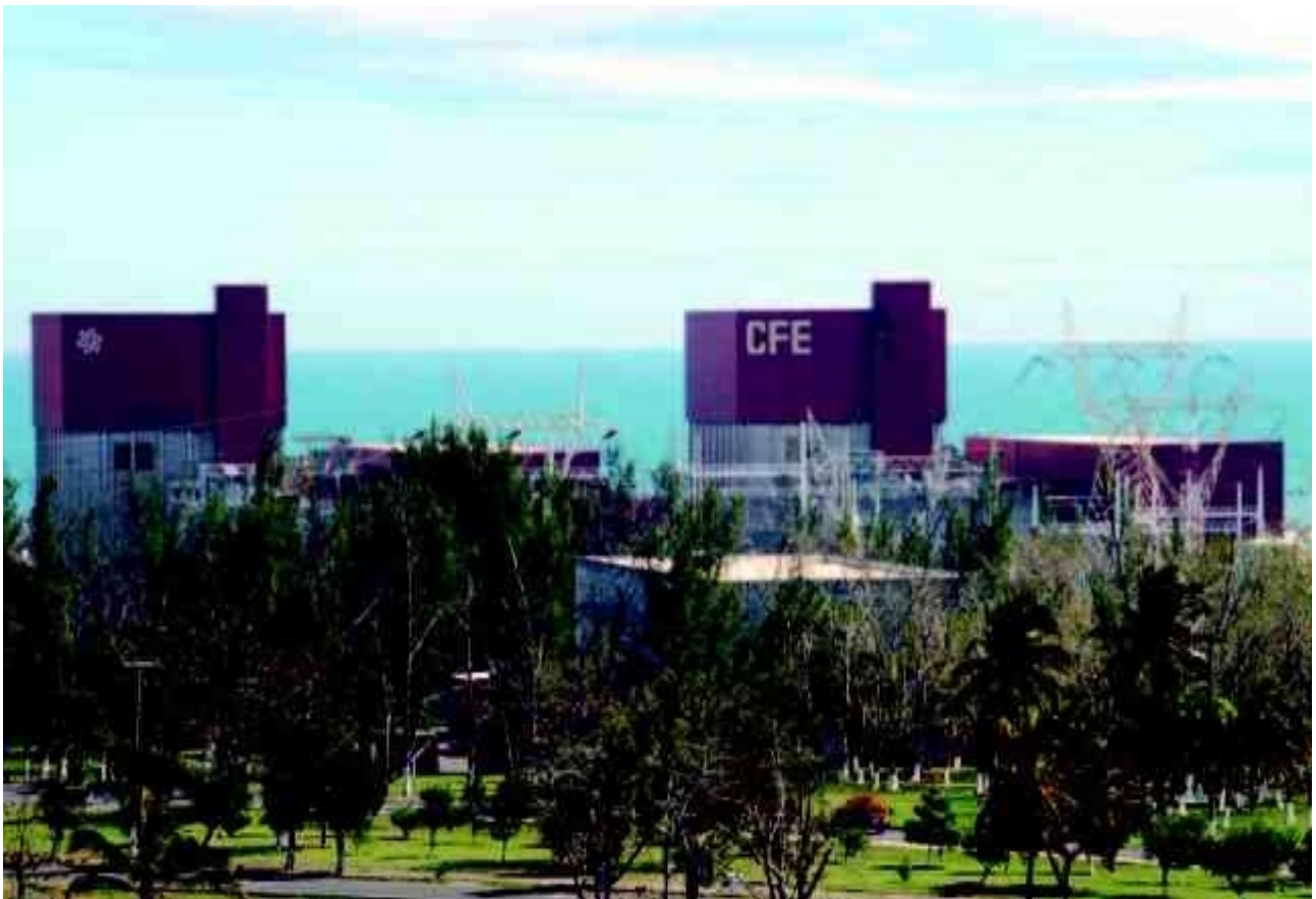
La centrale nucleare di Laguna Verde in Messico (Foto: CFE)
