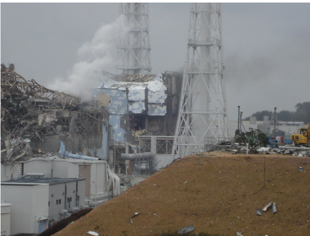
Am Dienstag kam es zur Explosion eines dritten Reaktorgebäudes (Bild: tepco).
